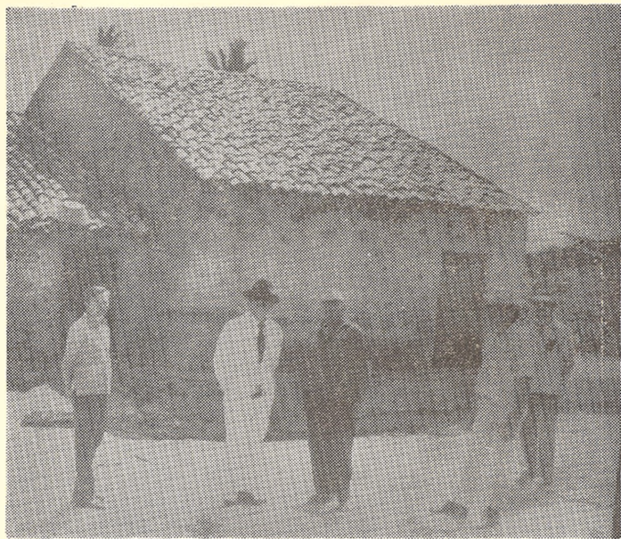
Parte traseira da casa de Chico Chicote, em cujas paredes ainda são vistas marcas de balas.
