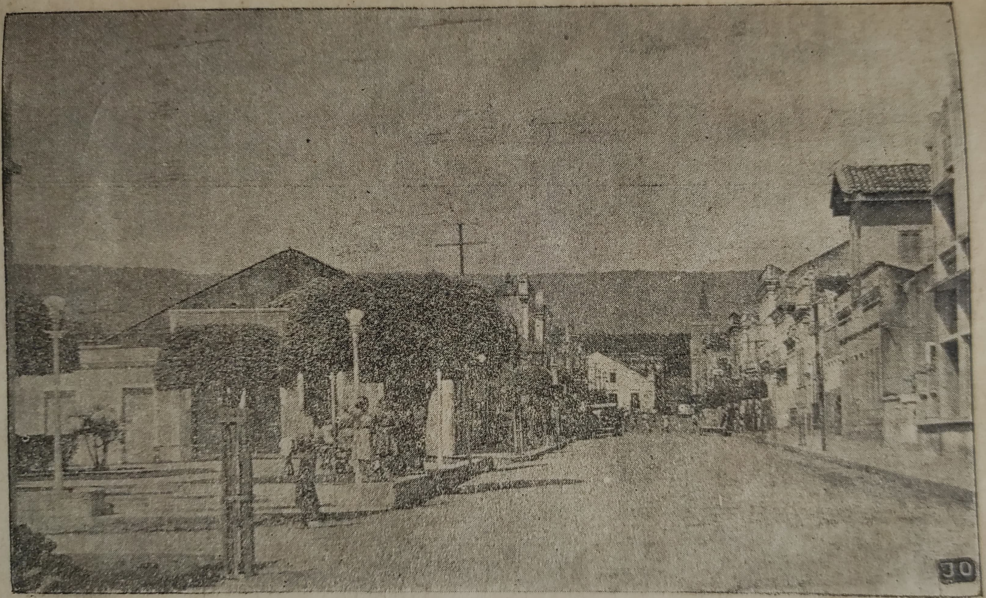
Trecho da Rua João Pessoa
