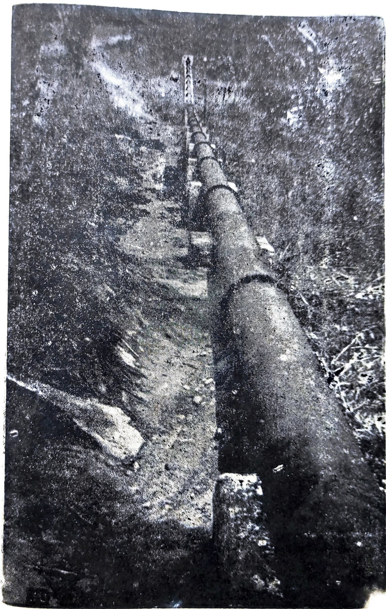
Outra aspecto do encanamento da Máquina Hidro-Electrica
