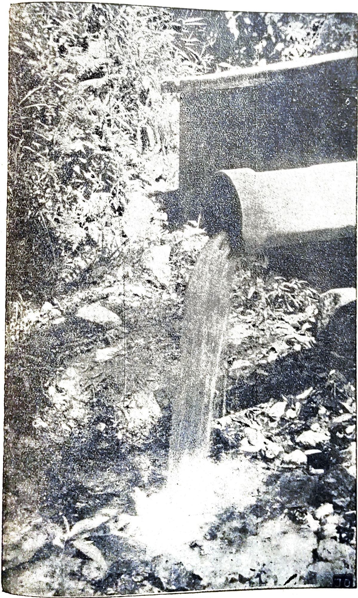
Fonte do rio Graaigeira - Ne-se transbordando a "ladrião" da laque de captação d'agua
