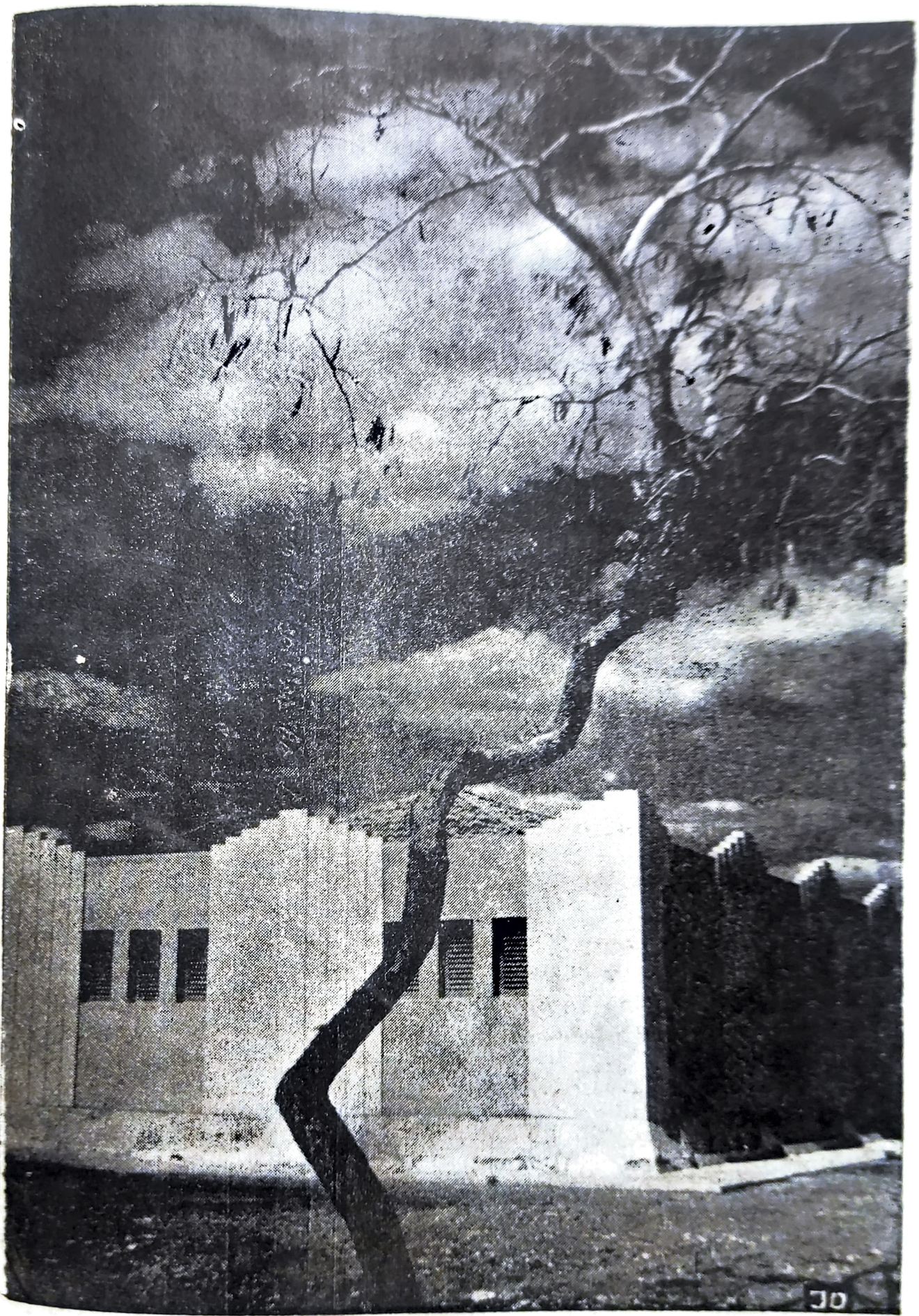
Caixa d'agua do serviço de Abastecimento
