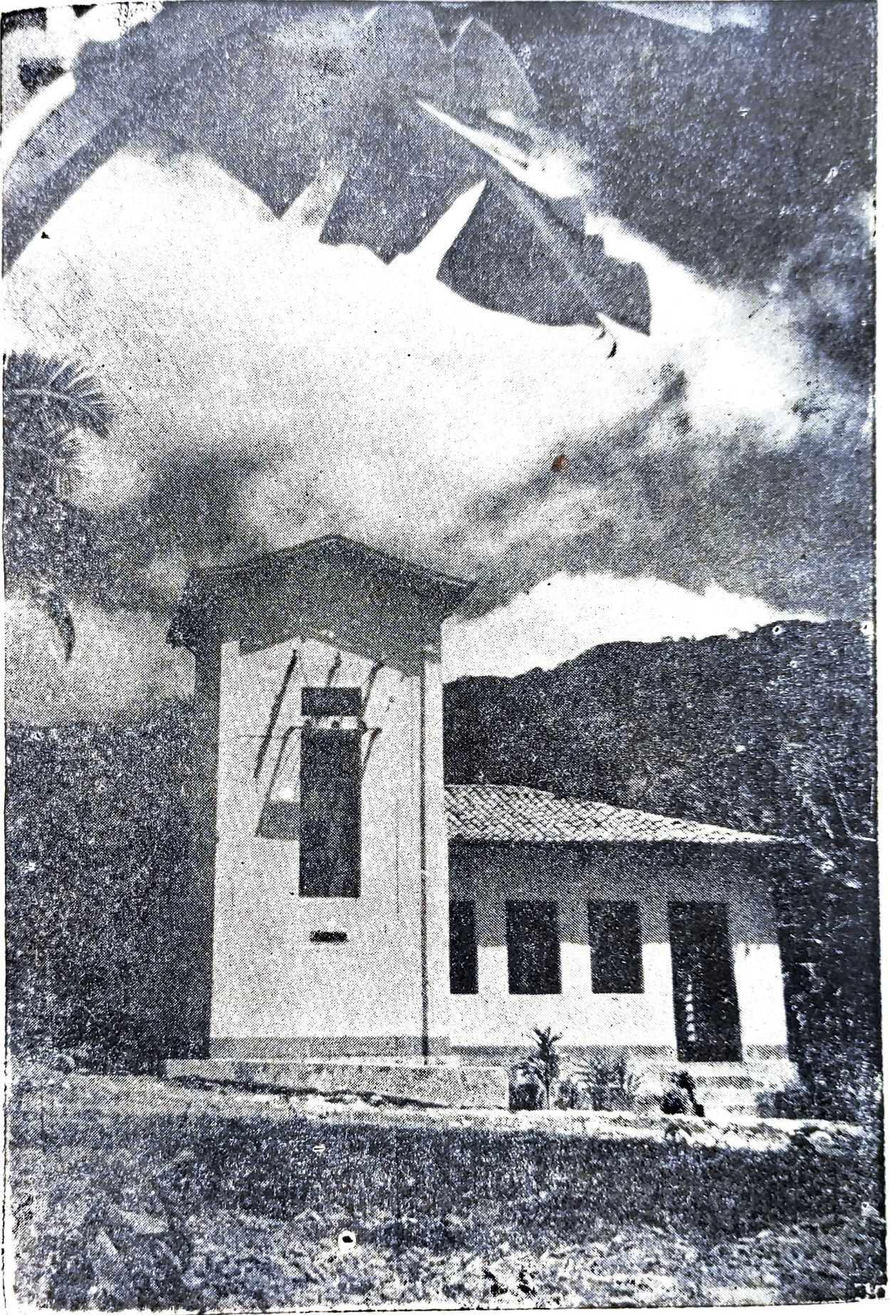
Visita da Casa de Força da Usina Hidra-Eletrica
